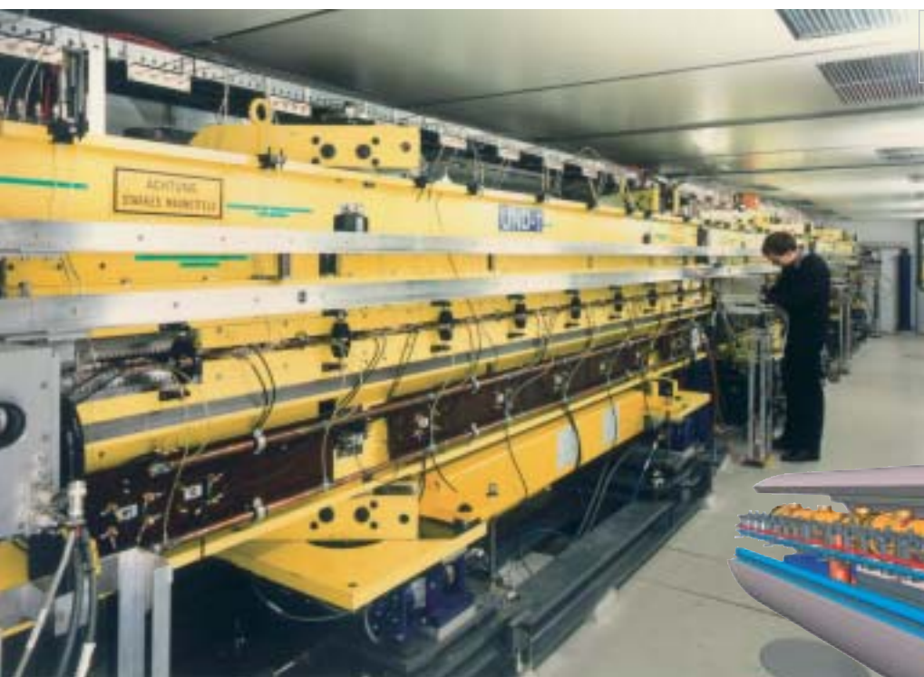
Frielektronlasern under uppbyggnad.
