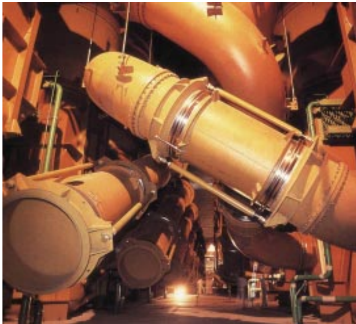
Rör innehållande filter, genom vilka \text{UF}_6 passerar.
